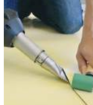
TRIAC ST: сварка рулонных полимерных материалов при использовании прикаточного ролика
